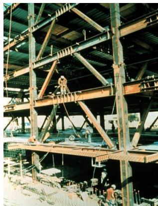
Figura 3. Ejemplo de estructura con arriostramientos excéntricos.
