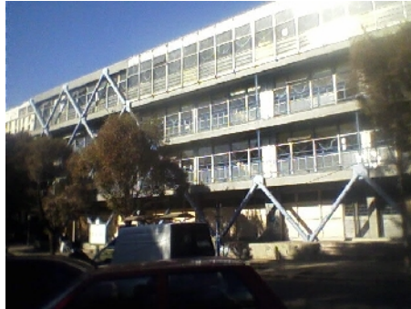
Figura 1 . Reacondicionamiento edilicio por intermedio de diagonales concéntricas (Escuela Normal-Mendoza).
