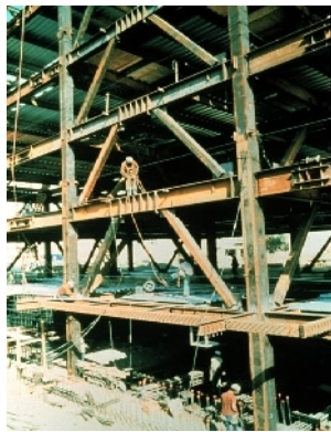
Figura 3. Ejemplo de estructura con arriostramientos excéntricos.
