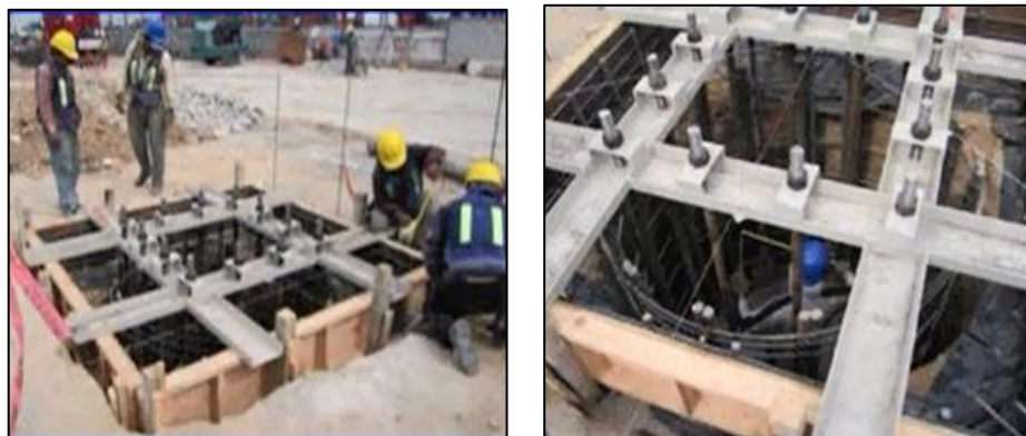
Figuras 2a y 2b: Colocación de plantillas metálicas para fijarse a las cimbras
