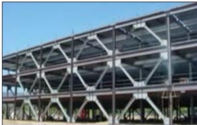
Figura 5: Estructura mediante arriostramientos
