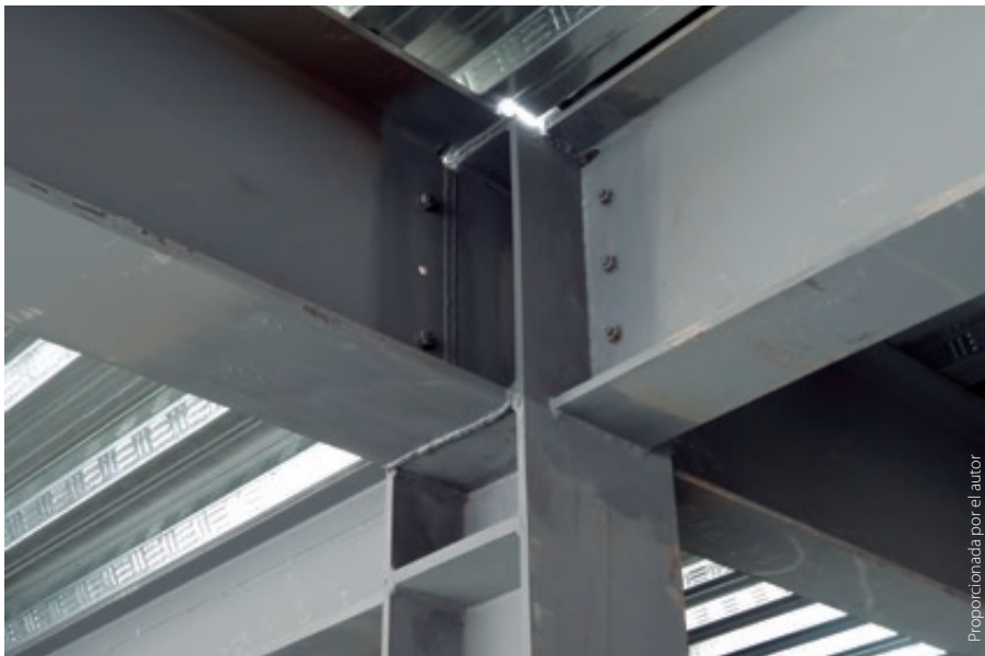
FIGURA 2. Conexiones trabe-columna en zonas sísmicas.
