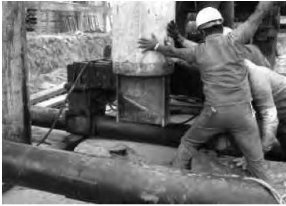
Foto 2 – Pilotes Mixtos (hormigón-perfil metálico) para apoyo en roca.
