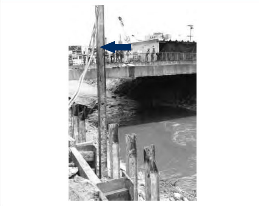
Foto 4: Pilote Metálico del puente Wandenkolk removido después de más de 20 años de uso
