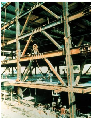
Figura 3. Ejemplo de estructura con arriostramientos excéntricos.
