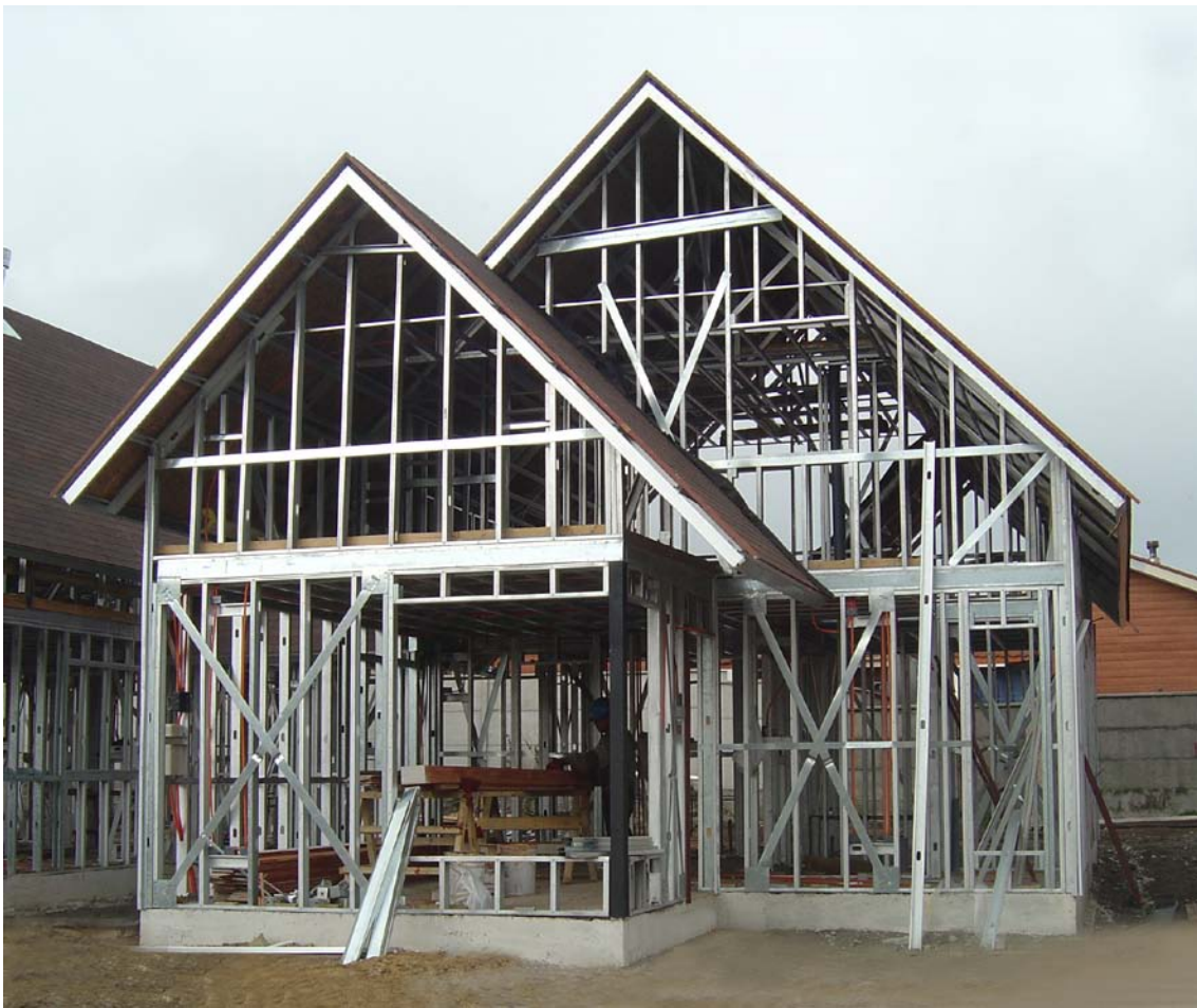
Figura 1 Estructura de Steel Framing de vivienda de dos niveles-Gentileza de FORMAC SA – Chile
