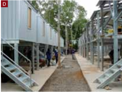
Fotografía 7. A: Transporte en botes del material; B: Fundaciones autoperforantes; C: Montaje; D: Viviendas refugio terminadas.
